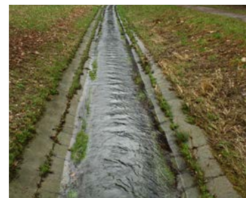
Potok Glinščica z betonsko strugo
