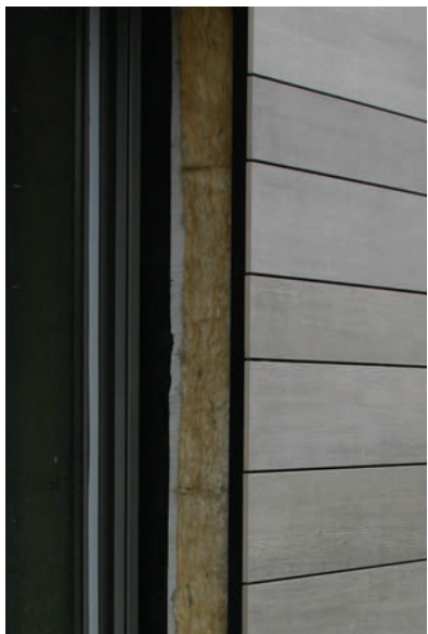
Hišo izoliramo in s tem zmanjšamo uhajanje toplote v okolico.
