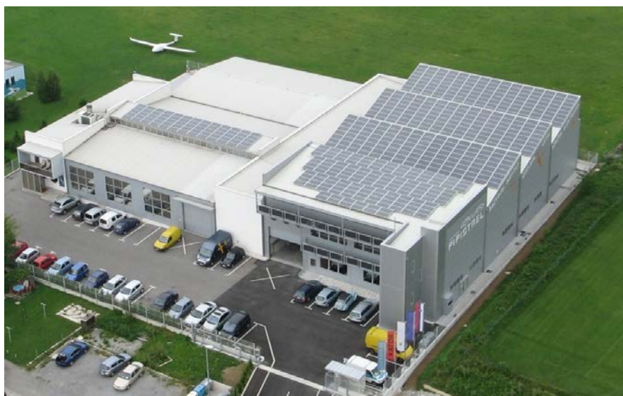
Sončna elektrarna na strehi podjetja Pipistrel v Ajdovščini
