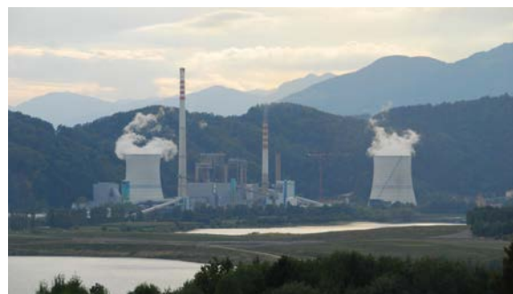
Termoelektrarna v Šoštanju. Veliki široki »dimniki«, iz katerih se vali bel dim, sploh niso dimniki, temveč hladilni stolpi, bel »dim« pa je vlažen zrak. Torej neke vrste oblak. Dimniki so ozki in visoki.
